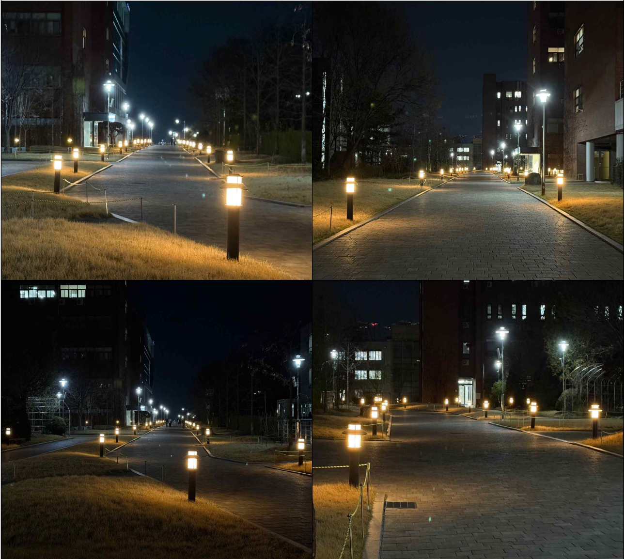
사색의 길 조명 보수 후
