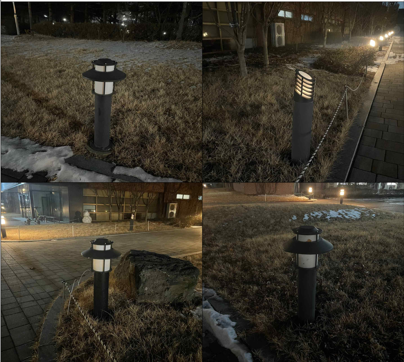
사색의 길 조명 보수 전
